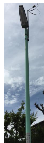
写真2 土木事務所管理
